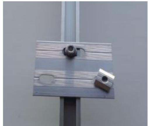
Schiebe nun das Montageprofil-H 1,70m in die bereits eingeschraubten Nutensteine ein, sodass die beiden Montageprofile-H 1,10m miteinander verbunden werden.
